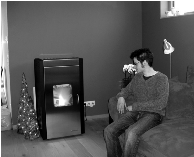
CHRISTOPHE DEBRABANDER: "WE STOKEN HOOFDZAKELIJK MET DE ZON EN DE HOUTPELLETKACHEL. HET VERBRUIK AAN PELLETS IS IN HET 4 MAANDEN DURENDE STOOKSEIZOEN BEPERKT TOT MAXIMAAL 1 ZAK KORRELS (OF 3 €) PER DAG."
